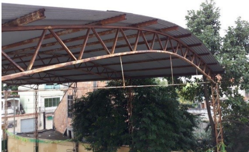
Foto nº 8 – Detalhe da viga metálica da quadra coberta apresentando oxidação
