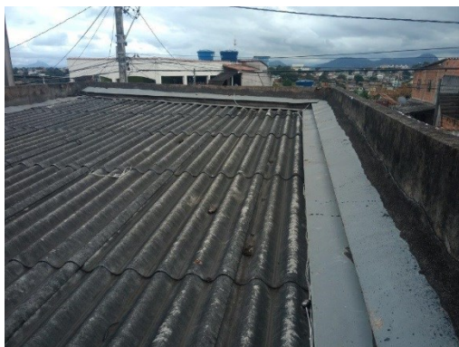
Foto nº 4 – Vista da cobertura do Bloco 1
