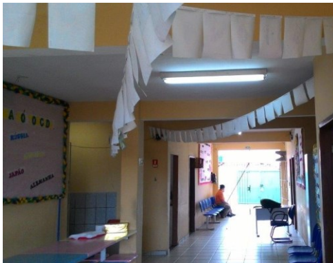
Foto nº 26 – Vista interna do refeitório localizado no Bloco 2, com destaque para saída de emergência ao fundo
