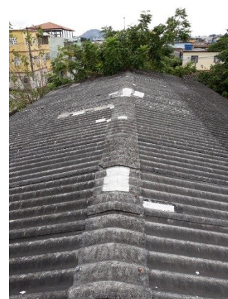
Foto nº 5 – Vista da cobertura do Bloco 3
