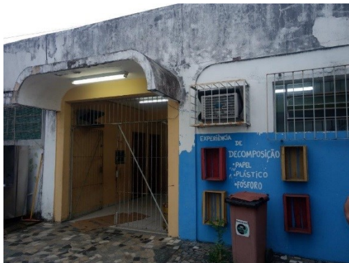
Foto nº 2 – Vista da fachada do Bloco 2
