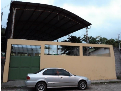
Foto nº 6 – Vista da entrada secundária pela Rua Boa Vista com a Quadra ao fundo
