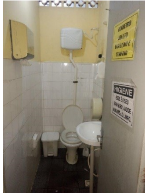
Foto nº 18 – Sanitário dos funcionários localizado no Bloco 2
