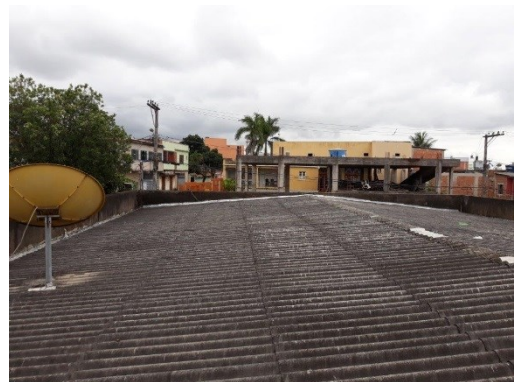
Foto nº 3 – Vista da cobertura do Bloco 2
