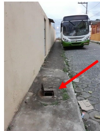
Foto nº 29 – Detalhe da calçada na Rua São benedito com caixa de ligação de esgoto para rede pública
