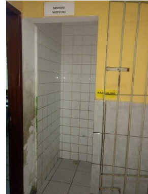
Foto nº 19 – Porta de entrada do sanitário masculino dos alunos localizado no Bloco 2
