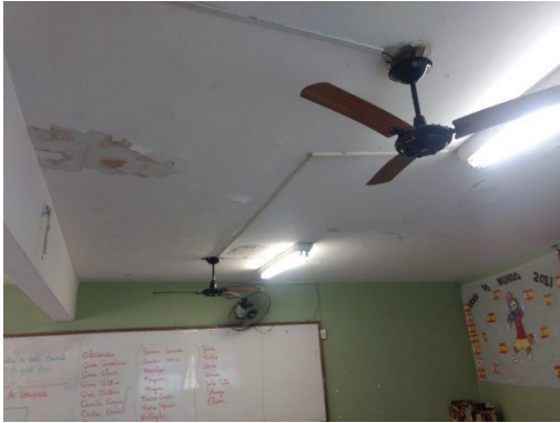
Foto nº 12 – Sinais de infiltração no teto da sala de aula do Bloco 1
