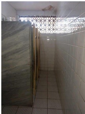
Foto nº 20 – Vista interna do sanitário masculino dos alunos localizado no Bloco 2
