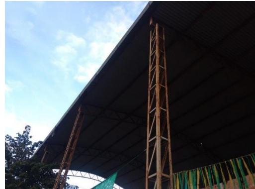
Foto nº 9 – Detalhe do pilar metálico da quadra coberta apresentando oxidação
